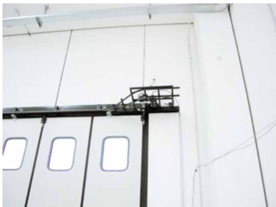
Dettaglio guida superiore versione LG predisposta alla motorizzazione. LG version, predisposed for motorization, upper rail detail.
