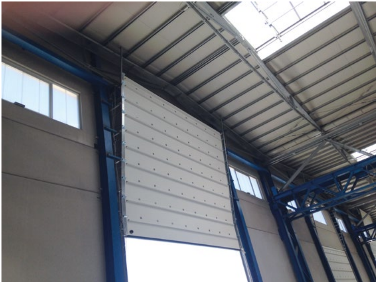
OMEGA DI RINFORZO E DOPPIE CERNIERE LATERALI PER PORTONI DI GRANDI DIMENSIONI REINFORCED WITH OMEGA SHAPED BARS DESIGNED BY SILVELOX
