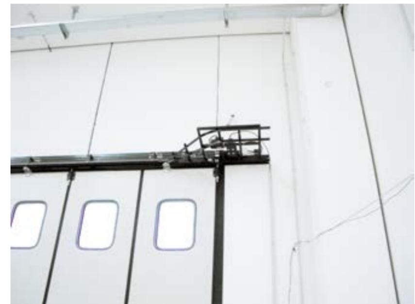
Dettaglio guida superiore versione LG predisposta alla motorizzazione.
