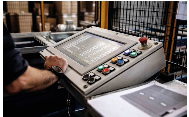
Sistema di controllo automatizzato. Automated control system.
